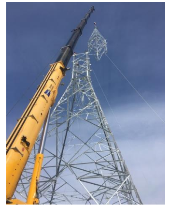
Grue hydraulique 350 T – Installation pylônes Complexe hydroélectrique La Romaine-4 – près de Havre-St-Pierre Mars 2019 (Crédit photo : Ian Corbin, grutier)
