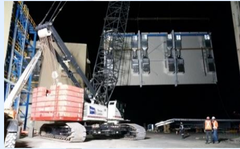
Levage du mur G2
