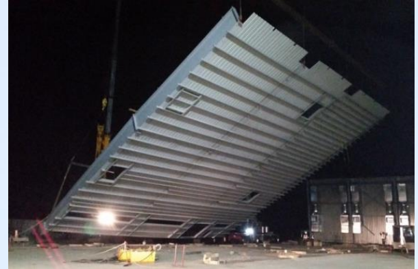
Relevage du mur K
