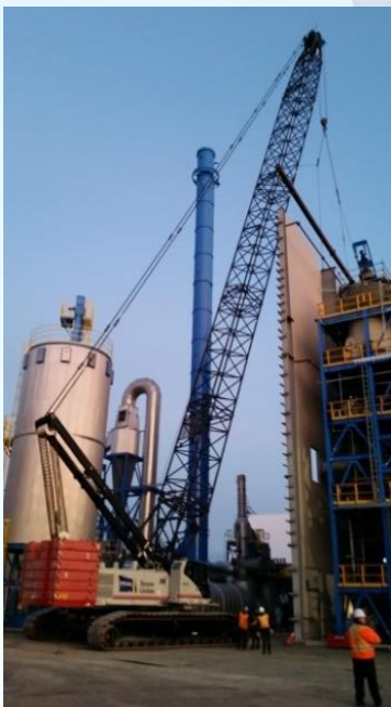
Mur K en position finale
