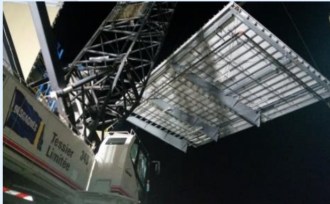
Levage du toit
