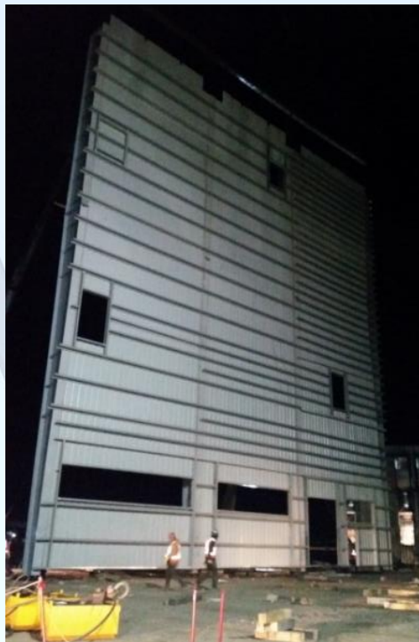
Mur K en position verticale
