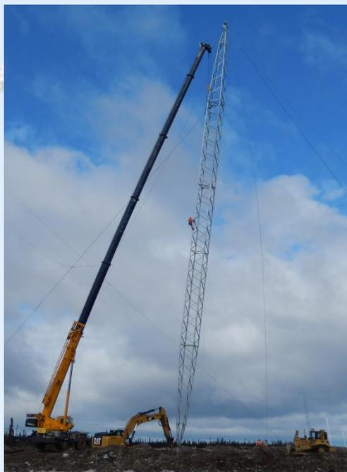
Dans la foulée du projet du complexe hydro-électrique La Romaine, plusieurs lignes haute tension ont été érigées et d'autres le seront au cours des prochaines années. Au cours du printemps, trois grues tout-terrain Grove RT9150E se sont assurées d'établir de nouveaux standards d'efficacité en matière d'érection de tour.
